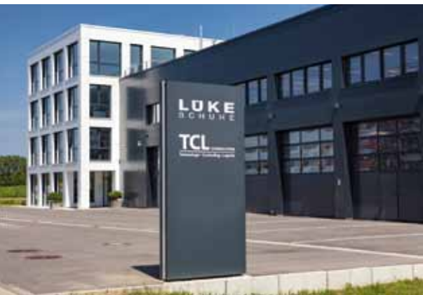
Holzfertigbauweise mit Hybrid-Funktion in Kfw 70 Standard. Davorgesetzt wurde eine individuell für TCL geplante Fassade aus Aluminium-Profilen.
