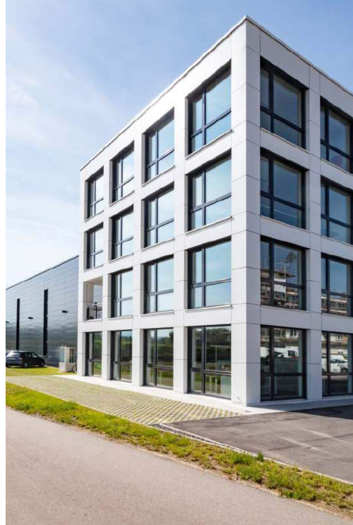
Holzfertigbauweise mit Hybridfunktion in KfW-70-Standard. Davorgesetzt wurde eine individuell für TCL geplante Fassade aus Aluminiumprofilen.
